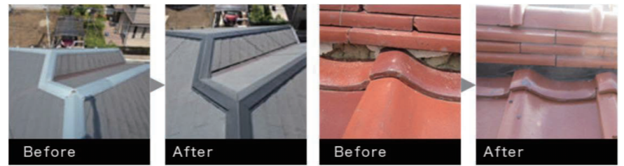
【板金屋根】 風災で痛んでしまった貴板と棟板金をすべて新しく交換し、釘の頭をシーリング処理しました。 【瓦屋根】 風災によって剥がれてしまった漆喰もご覧の通り。今回は白い漆喰から黒い漆喰に変更しました。
