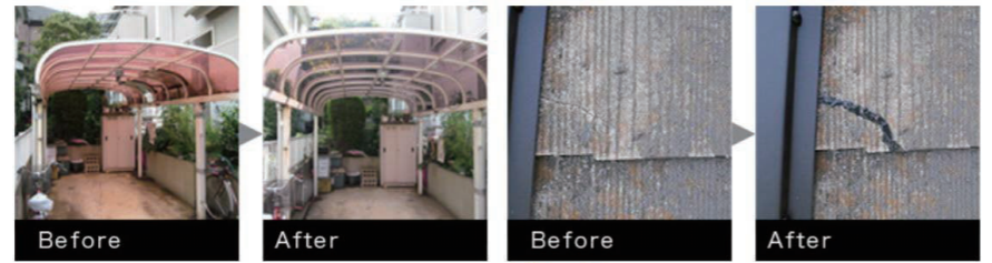
【カーポート】 強風で割れてしまったカーポートを全て外して骨組みだけになりました。新しいポリカーボネートをはめて、カーポートの修理は完了です。 【板金屋根】 雪害によって痛んだ板金及び貴板を総交換し、雨樋部分も交換しました。
